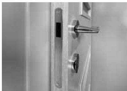
zamek magnetyczny w skrzydle drzwiowym
